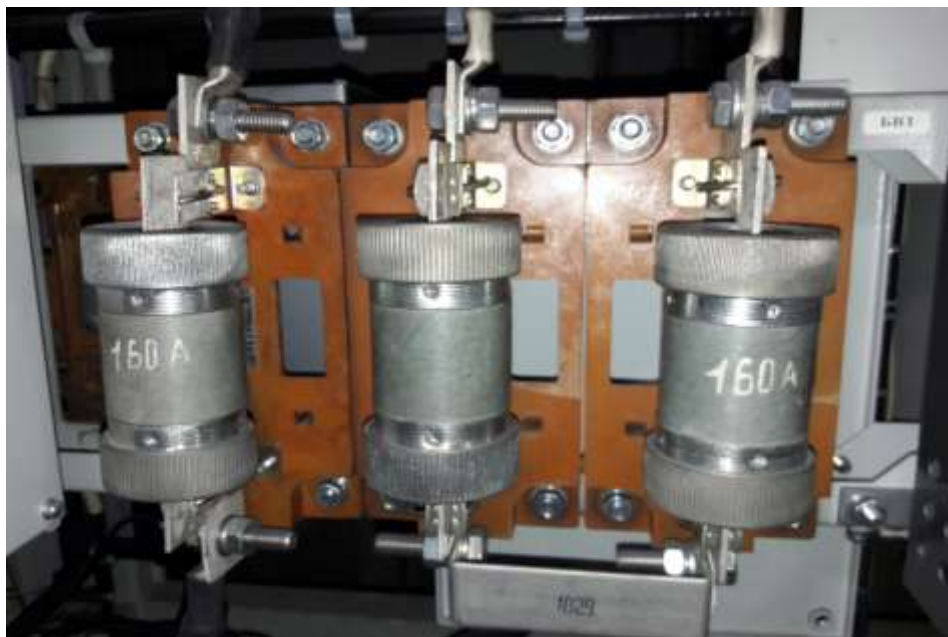
Рисунок 1.58 Осмотр предохранителей
