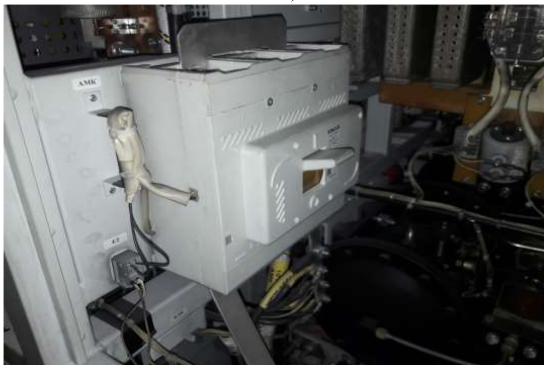
Рисунок 1.59 Осмотр автоматов защиты и питания (а) осмотр автомата защиты и питания компрессора (б)
