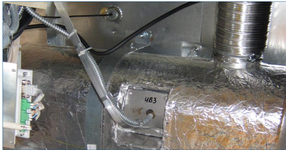
Датчик приточного воздуха- tпр
