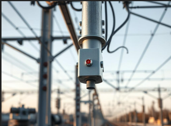
Интеграция индикаторов износа изоляции
