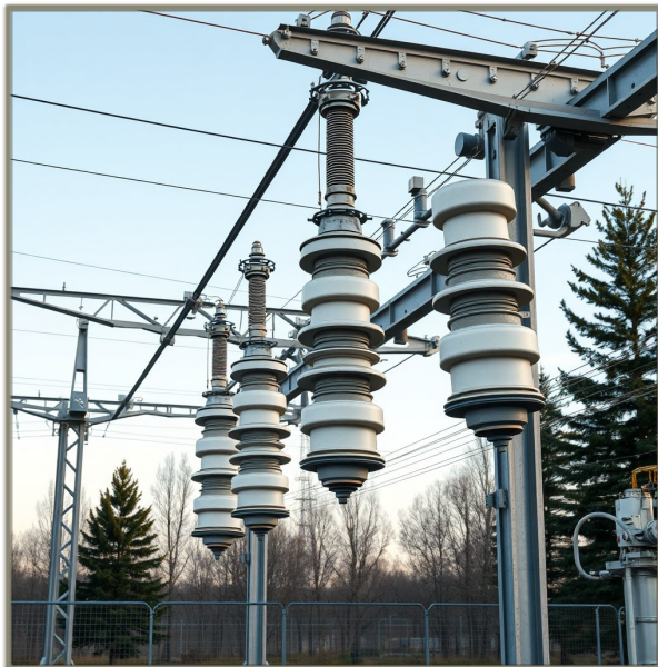
Подстанция «Москва-110кВ»: обновление изоляторов
