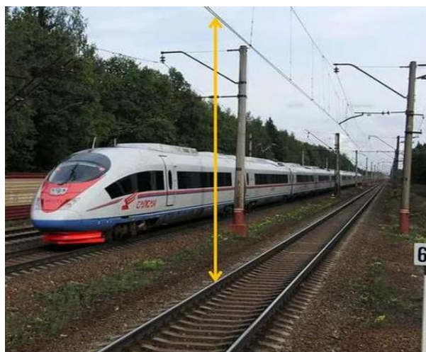
Рис. 12. Высота подвеса контактного провода
