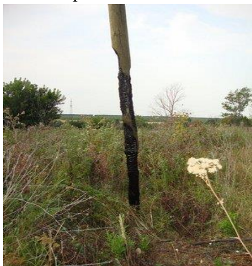
Рисунок 14 - Последствия возгорания опор
