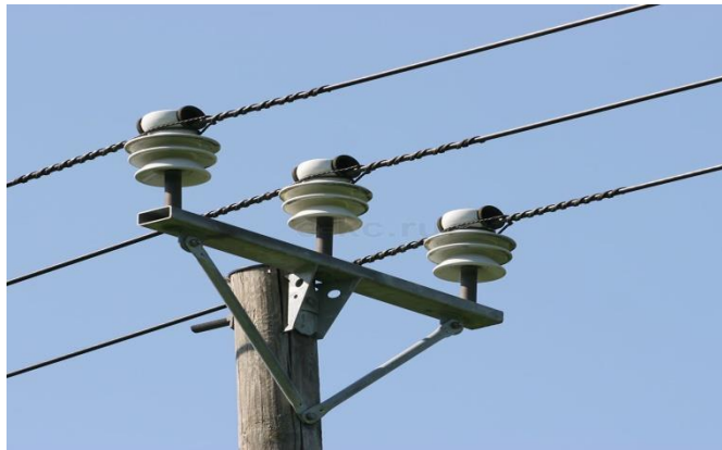
б) штыри стальные типа ШТ для крепления изоляторов на траверсах. Они имеют типоразмеры: ШТ-16Д, ШТ-12Д – для оснастки деревянных траверс, ШТ-16С и ШТ-12С - для оснастки стальных траверс;
